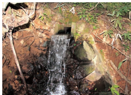
中水道の石樋
