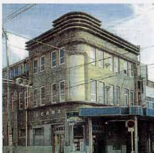
上部に5本のジャバラが残る 昭和60年当時の五臓圓ビル
